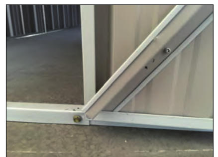
Door Bracing - Bottom
